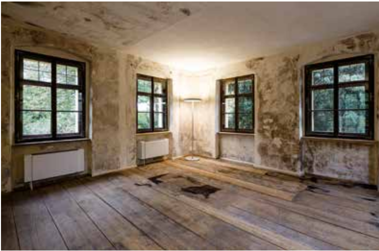
links Festsaal im Obergeschoss nach Sanierung 2017.
